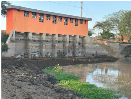
Imagen. compuertas villa rosa: se observa dique provisional terminado (lado canal del dique)
