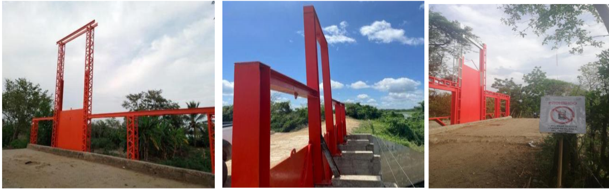
Imagen. Compuertas con acabado final
