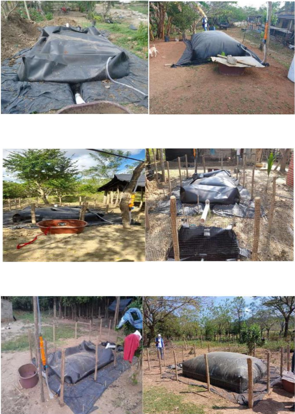
Verificación del funcionamiento de Biodigestores instalados
