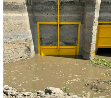
Imagen. Compuertas Villa Rosa: se observa labores de instalación de compuertas terminado (con aplicación de anticorrosivo y pintura epoxica sobre las compuertas instaladas) - (lado canal del dique)
