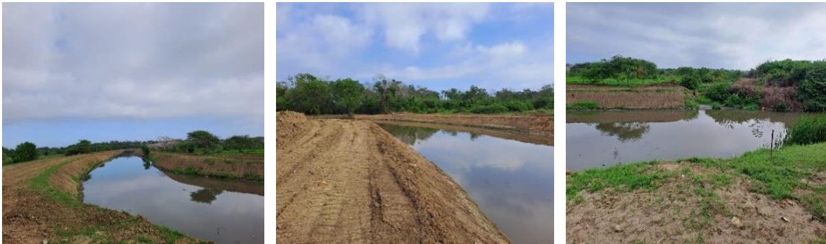
Imagen. Obras de intervención del Arroyo León
