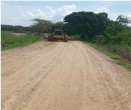
Imagen. Relleno con material seleccionado para la corona del dique existente (K8+191.11 / K3+900).
