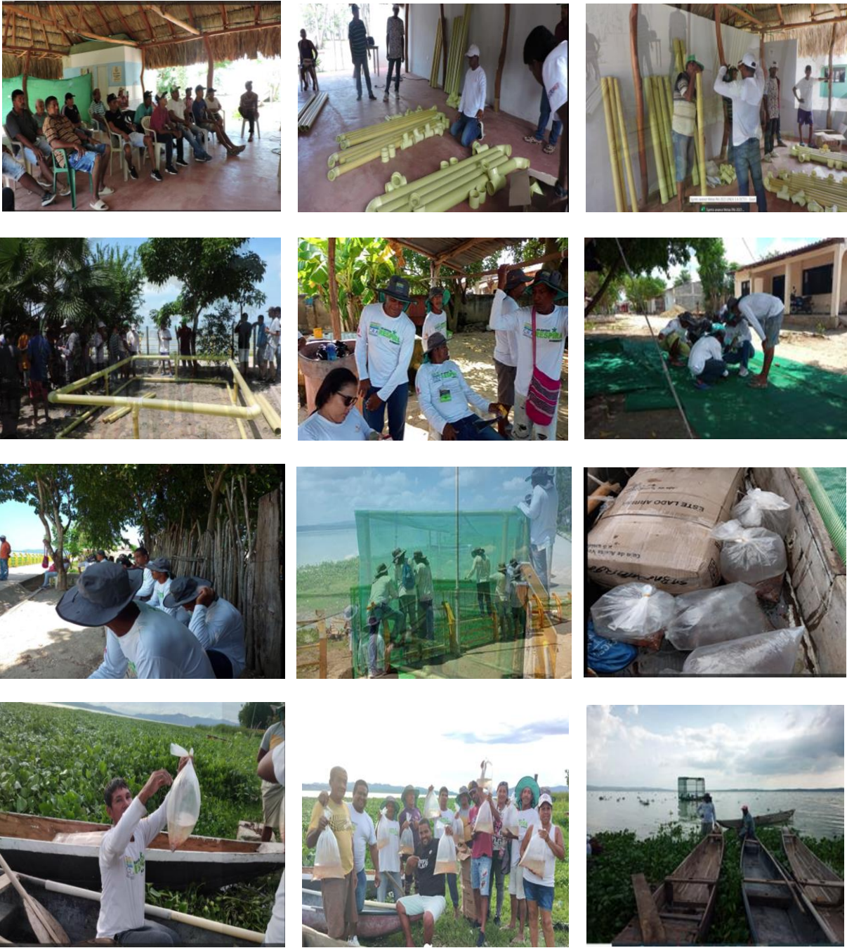
Imagen. Implementación del proyecto productivo, construcción de jaulas flotantes y siembra de alevinos de tilapia roja
