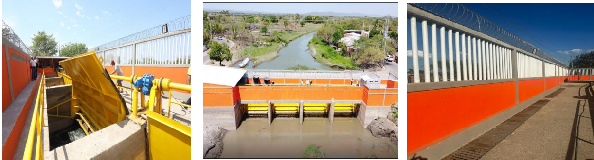
Imagen. Compuertas El Porvenir - labores terminadas en las instalaciones de las compuertas
