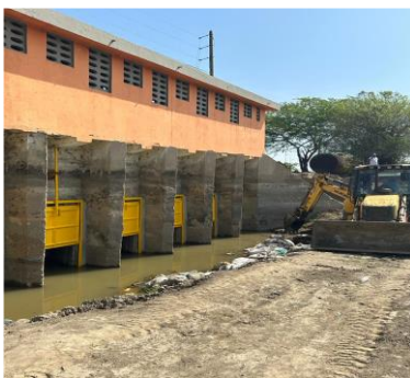
Imagen. Compuertas Villa Rosa: se observa labores de instalación de compuertas terminado (con aplicación de anticorrosivo y pintura epoxica sobre las compuertas instaladas) - (lado canal del dique)
