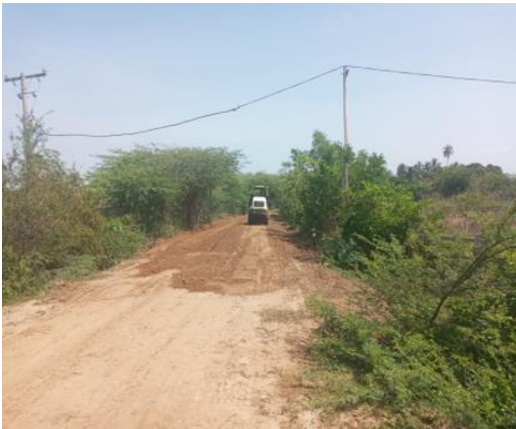
Imagen. Relleno con material seleccionado para la corona del dique existente (K8+191.11 / K3+900).
