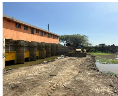
Imagen. compuertas villa rosa: se observa dique provisional terminado (lado canal del dique)
