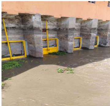
Imagen. Compuertas Villa Rosa: se observa labores de instalación de compuertas terminado (con aplicación de anticorrosivo y pintura epoxica sobre las compuertas instaladas) - (lado canal del dique)
